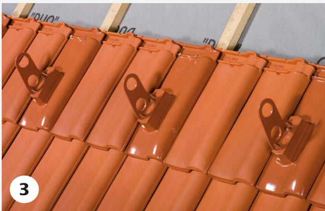
Der Stützabstand darf bei Schneefangsystemen maximal 80 cm betragen. Je nach Schneelastzone ist dieser Abstand zu minimieren.
