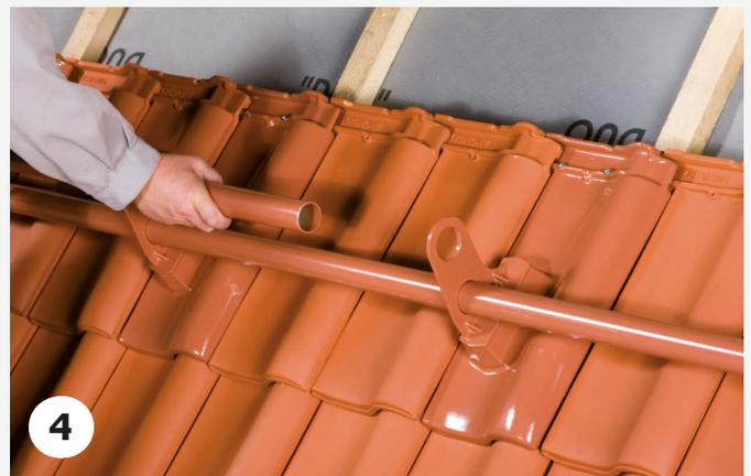
Die Rundrohre werden durch jede Gebirgsschneefangstütze durchgeführt. Eine zusätzliche Befestigung ist nicht mehr notwendig. Bei Längen über drei Meter müssen die Rundrohre mit einem Verbinder versehen werden.
