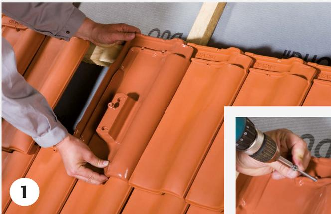
Das Alu-Grundelement wird in die Fläche eingedeckt und mit zwei korrosionsbeständigen Schrauben an der Unterkonstruktion befestigt.
