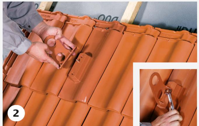
Die Gebirgsschneefangstütze wird auf dem Alu-Grundelement fixiert und anschließend mit der mitgelieferten Schraube befestigt.
